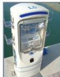
Fig. 1.3 – erogatore di banchina
